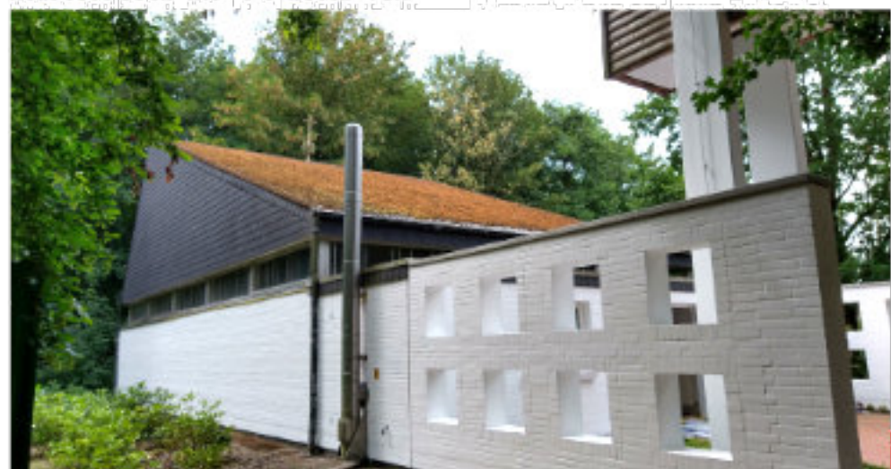
Die Kirche erstrahlt in neuem Glanz (unten)
